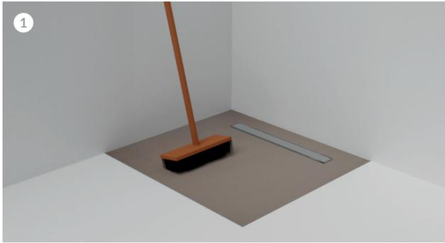
Preparate la superficie pulendola accuratamente e rimuovendo tutte le particelle di sporco e polvere. Pulite le pareti fino al soffitto lungo l'area della doccia, poiché anche queste devono essere sigillate.
