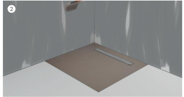
Applicate innanzitutto il primer incluso utilizzando un pennello o un rullo per verniciare sull'intera area da sigillare. Raccomandiamo di sigillare completamente l'intera area della doccia, comprese le pareti sopra l'area della doccia. Attendete che lo strato di primer applicato sia completamente asciutto.
