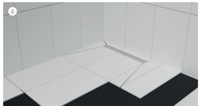
Successivamente, è possibile posare le piastrelle o applicare un altro tipo di rivestimento per il pavimento nella zona della doccia. Per quanto riguarda la posa delle piastrelle, raccomandiamo l'uso di un collante flessibile per piastrelle e l'uso di distanziatori per piastrelle. Riempire le fughe con stucco e sigillare la canaletta doccia con un sigillante siliconico flessibile.
