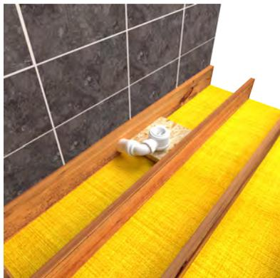
5. collegare un tubo di standard da 50 mm alla fine del sifone. Assicurarsi di riuscire a montare il sifone con il fissaggio superiore dall'alto del canale di scarico in acciaio. Se siete sicuri che il sifone è ben sostenuto nel punto giusto, utilizzate la colla siliconica per fissare il tubo del sifone al sistema di scarico. Ora eseguite un semplice test per verificare se l'acqua scorre correttamente nel sifone.
