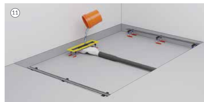
11. Collega lo scarico alla fognatura e esegui una prova d'acqua.
