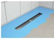
4. Applicare il sigillante liquido sulla superficie della flangia e sull'area circostante del pavimento.
